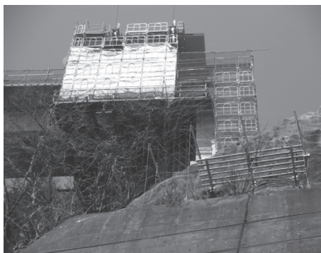
写真 - 5 側径間部施工状況 (A1 橋台側)
