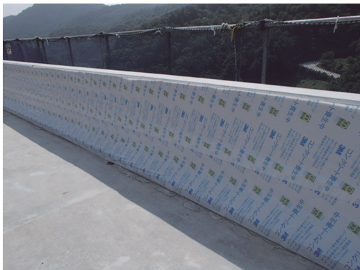
写真 - 6 脱型後の養生状況
