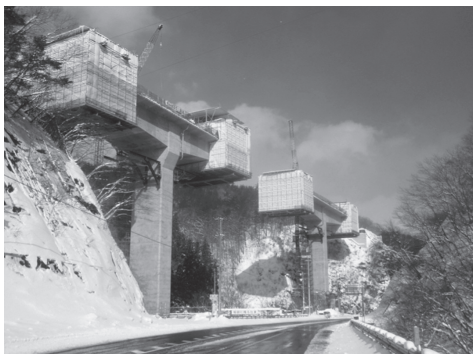
写真 - 2 張出し施工状況
