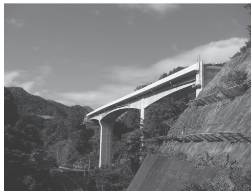
写真 - 8 完成写真
