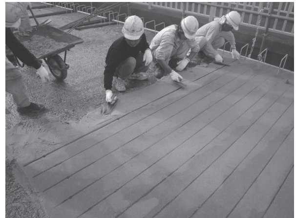
写真 - 7 樹脂モルタルおよび CFRP ロッドの施工
