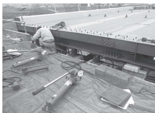
写真 - 14 ジャッキダウン状況
