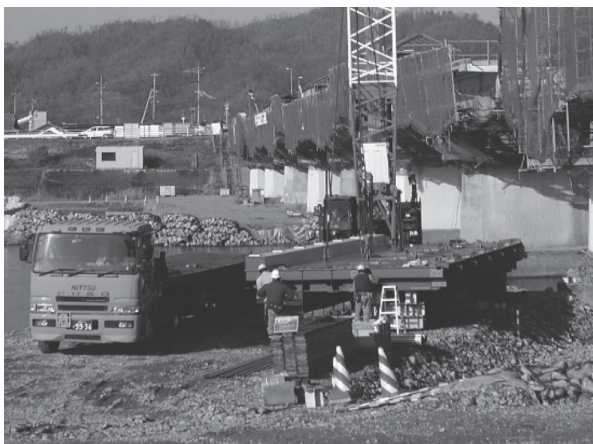
写真 - 11 地組状況
