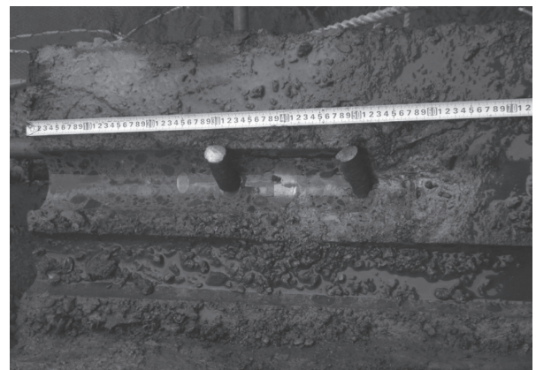
写真 - 2 アンカー鉄筋
