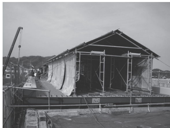
写真 - 13 現場溶接時養生状況
