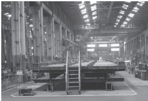
写真 - 10 実仮組立て状況
