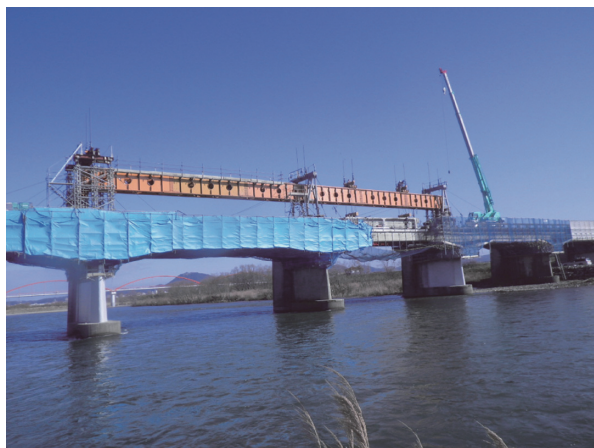
写真 - 3 架設桁による吊桁の撤去状況
