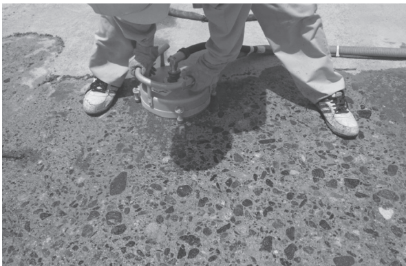
写真 - 5 下地処理状況
