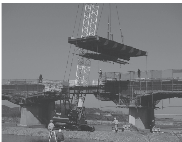
写真 - 12 鋼橋架設状況
