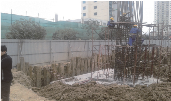
写真 - 13 現場における橋脚の鉄筋工の例 (上：日本企業，下：ベトナム企業)
