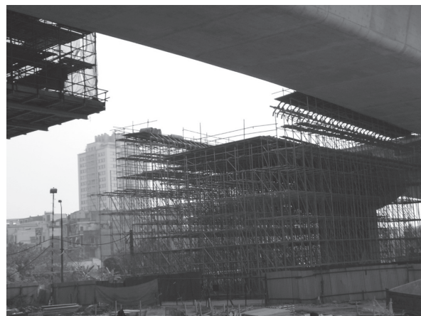
写真 - 11 くさび結合式型枠支保工システム
