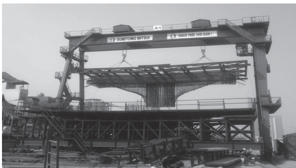
写真 - 9 大型門型クレーンによる地組鉄筋の移動と吊込
