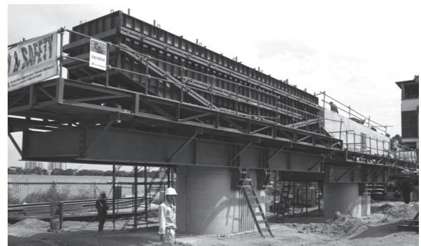
写真 - 8 脚頭部用大型型枠
