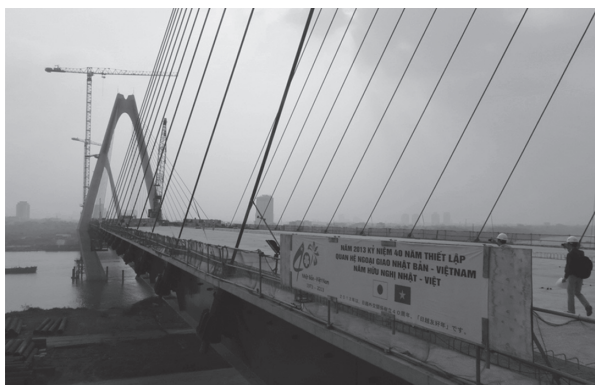
写真 - 1 ニャタン橋建設現場における日越外交樹立40周年を祝う横断幕
