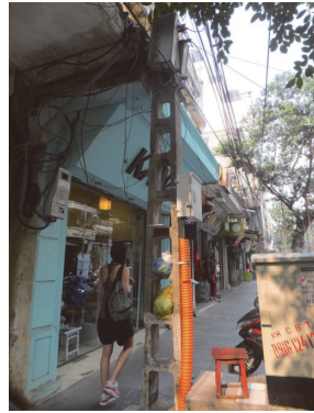
写真 - 14 コンクリート製の梯子の電柱
