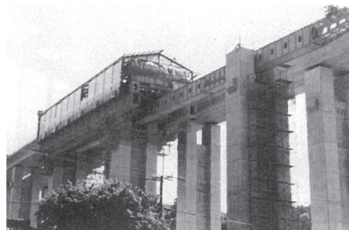
写真 - 3 サポートタイプ架設 1)
