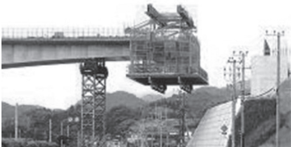
写真 - 4 仮支柱を併用して張り出す方法 1)
