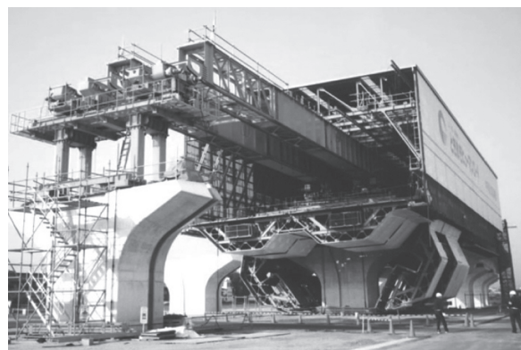
写真 - 2 ハンガータイプ架設 1)
