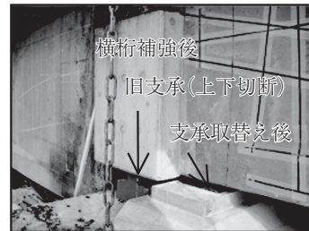
写真 - 4 補修工事完成後
