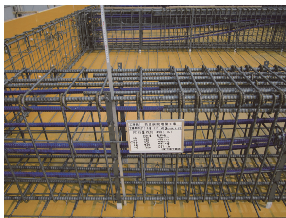
写真-2 PC鋼線の配線状況
