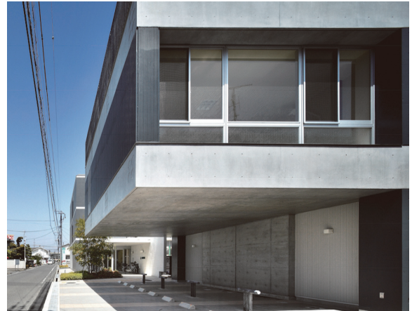
写真 - 5 6mの跳出し架構（無柱空間）
