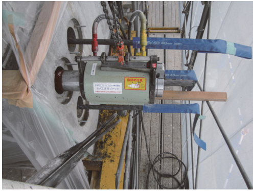
写真 - 4 PC 梁 (28.6 φ) 緊張時の状況
