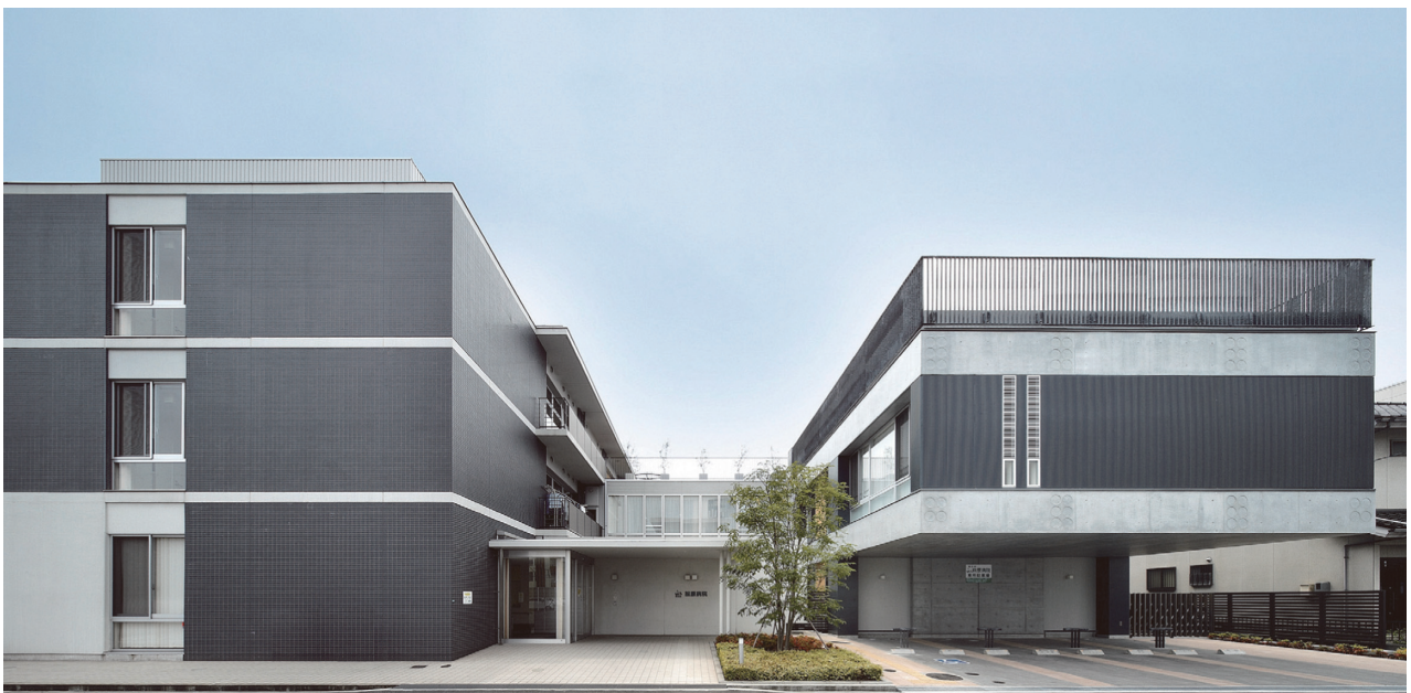
写真 - 7 前面道路からの既存建物（左）と増築建物（右）
