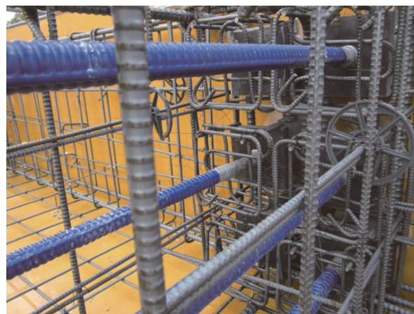
写真-3 PC梁端部納まり
