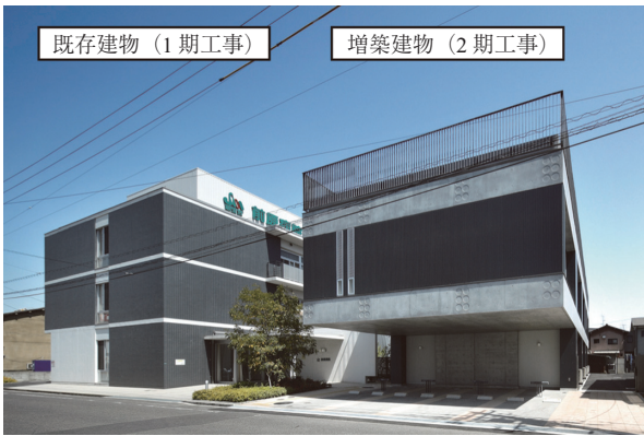
写真 - 1 外観写真
