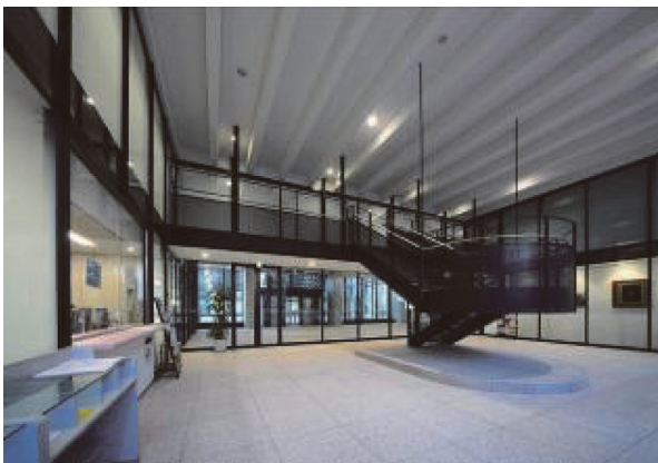
写真 - 4 PC床版内観（1階）
