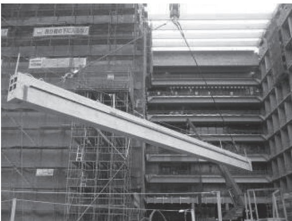
写真 - 8 ロングスパン梁の架設状況
