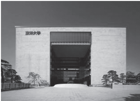
写真 - 2 正面（北面より）
