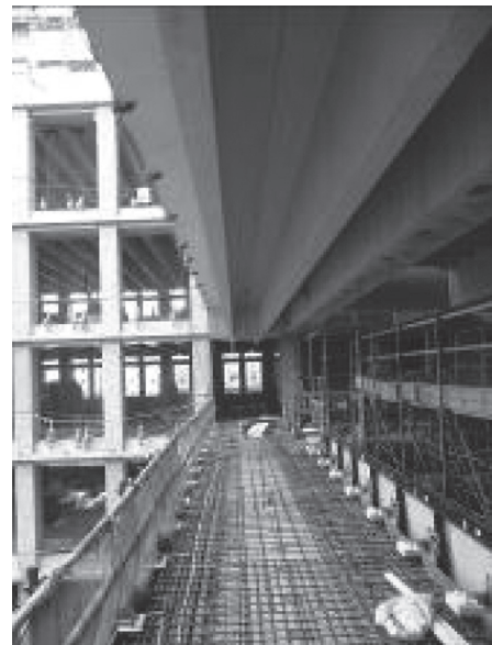
写真 - 10 ブリッジ PC 床版の施工状況
