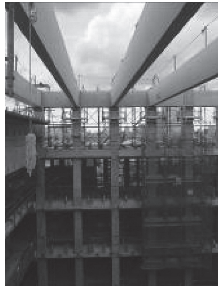
写真 - 9 トップライト PC 梁の架設状況
