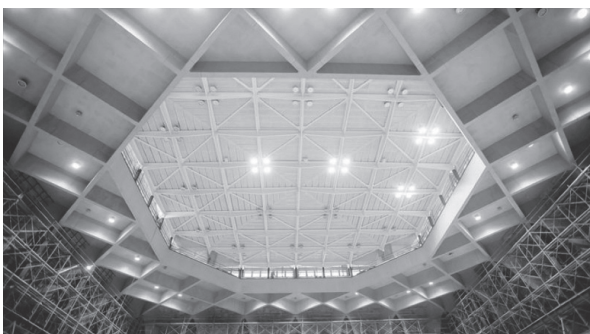
写真 - 8 支保工解体後
