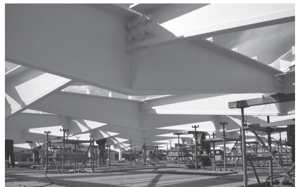
写真 - 11 ジャッキダウン後の状況
