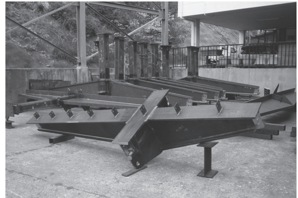
写真 - 10 鉄骨製作状況
