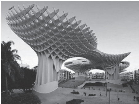
写真 - 2 プレートグリッドのイメージ
