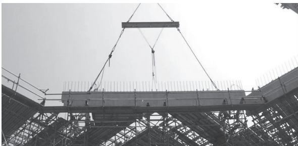
写真 - 7 PC 梁架設状況
