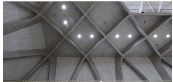
写真 - 14 プレートグリッド見上げ
