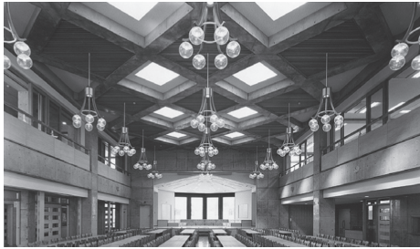
写真 - 1 RC 格子梁事例
