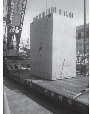
写真 - 5 柱運搬状況
