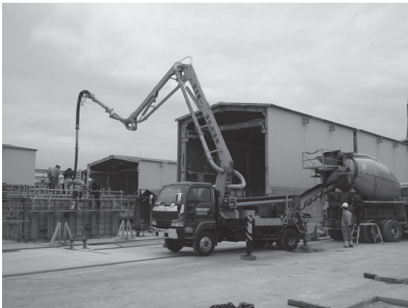
写真 - 3 大梁製造状況
