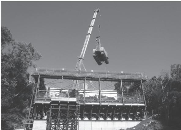
写真 - 10 65 t クローラークレーン揚重作業状況
