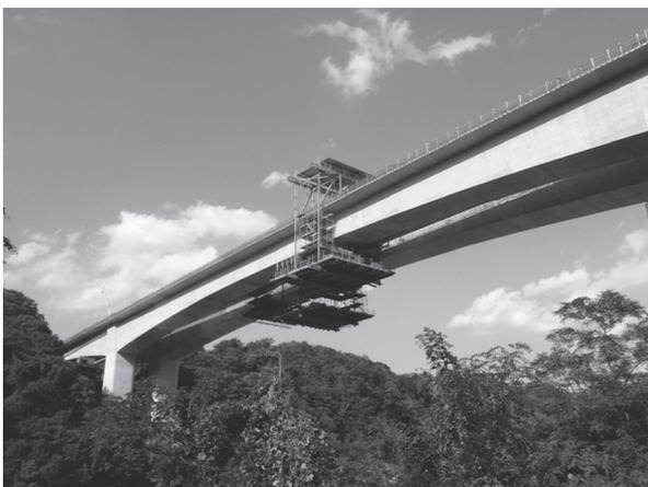
写真 - 8 中央閉合施工状況
