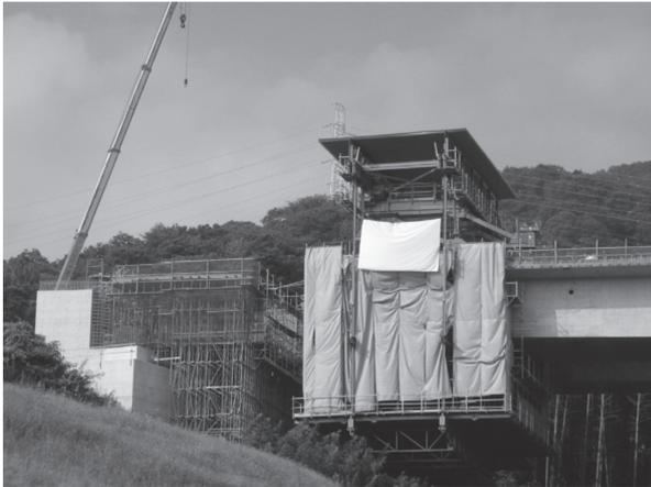
写真 - 7 側径間先行施工状況
