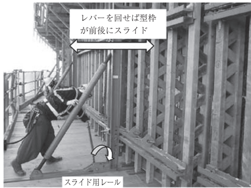
写真 - 2 型枠スライド状況 (前後)
