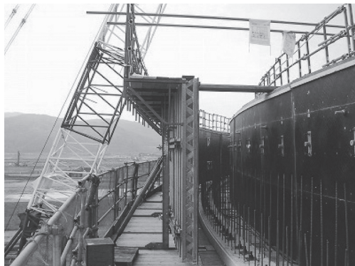
写真 - 3 型枠スライド状況 (後方へ)
