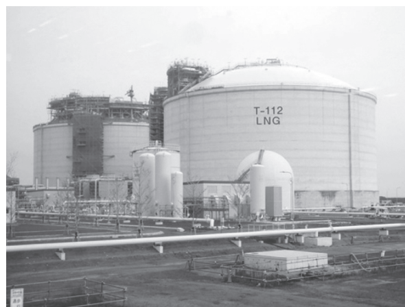
写真 - 8 全景写真
