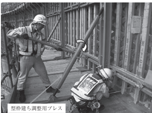
写真 - 5 型枠鉛直精度調整状況
