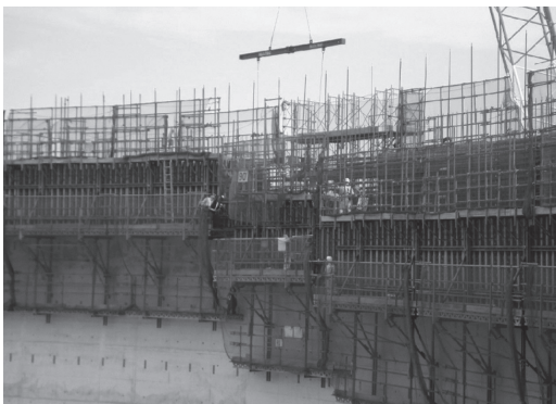
写真 - 4 型枠スライド状況 (上方へ)
