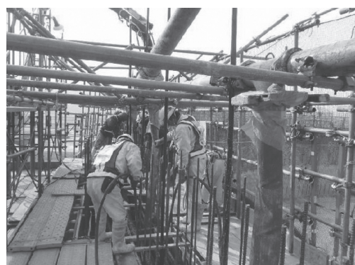
写真 - 7 配管設置状況
