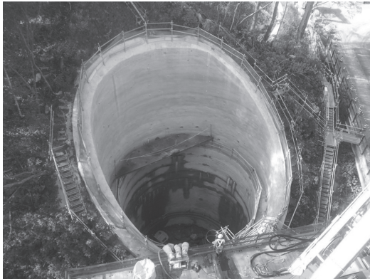
写真 - 3 竹割り型土留め工施工完了
