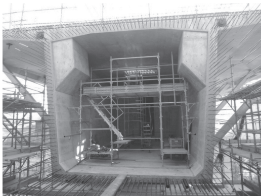
写真 - 10 水平加力突起
