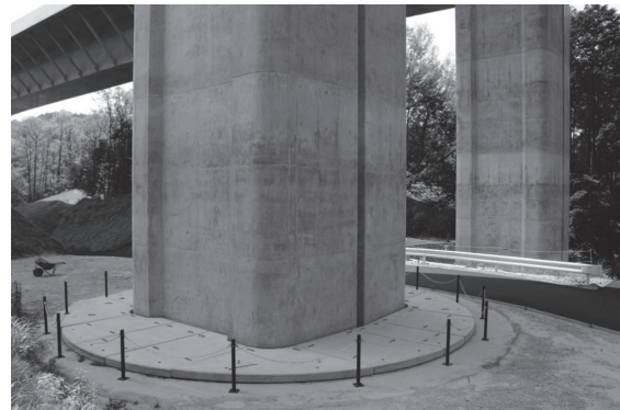
写真 - 5 掘込み式橋脚完成写真
