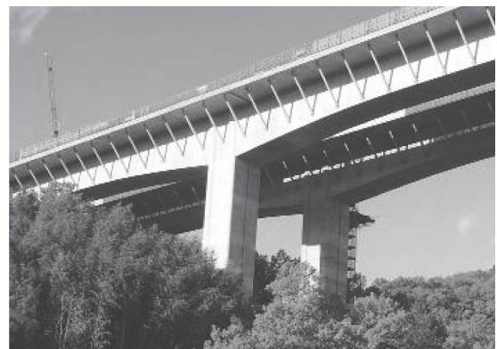
写真 - 2 P1橋脚
