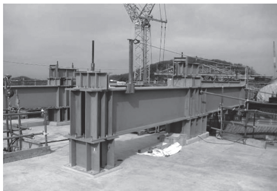
写真 - 11 鉛直調整装置
