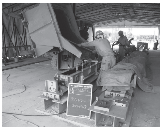
写真-9 ストラット製作状況
