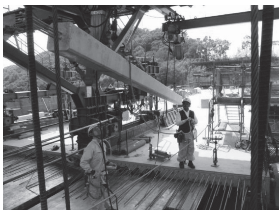
写真-7 ストラット設置状況
