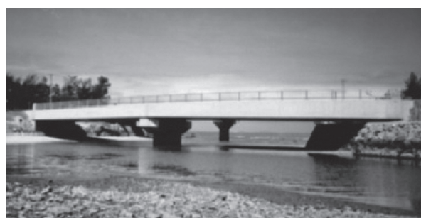
写真 - 1 屋嘉比橋の全景(手前:田嘉里川上流側・山側)
