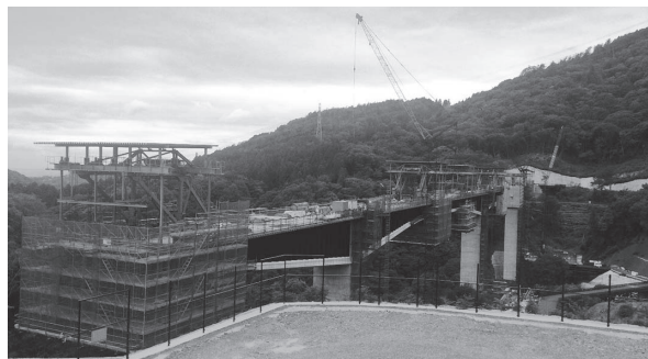
写真 - 3 下音羽川橋（下り線）全景
