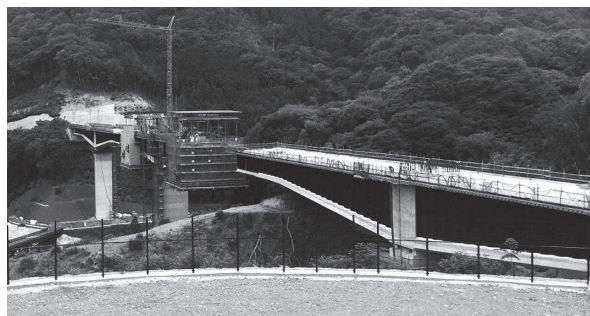
写真 - 2 下音羽川橋（上り線）全景
