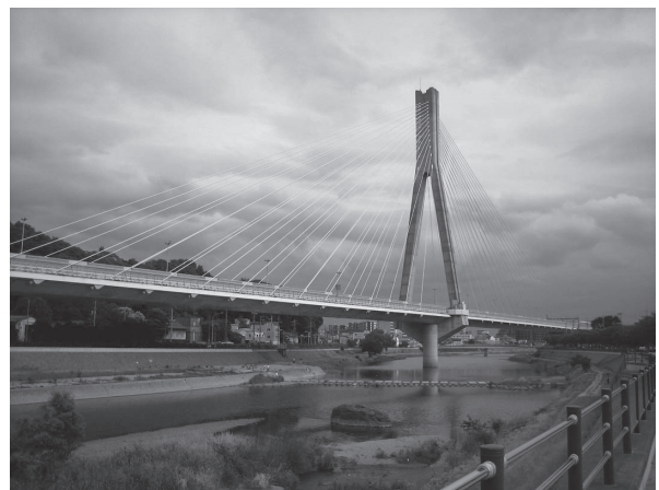
写真 - 8 新猪名川大橋 (全景)
