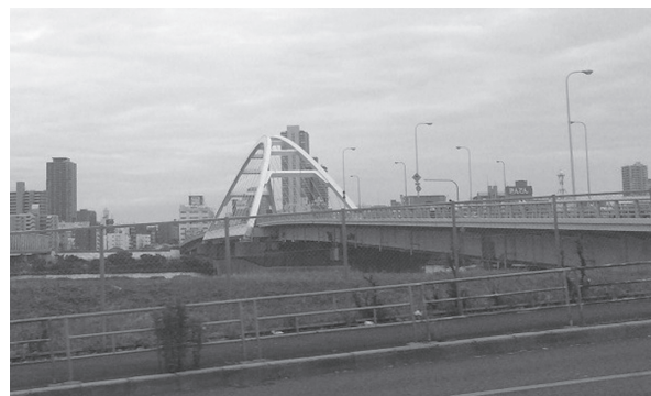
写真 - 11 長柄橋(車窓より)
