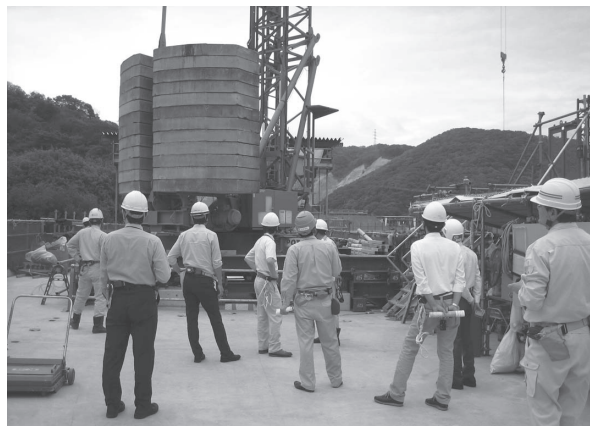
写真 - 4 P2 柱頭部見学状況
