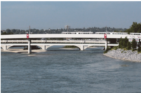
写真 - 6 Sunnyside C-Train 橋（手前の橋）
