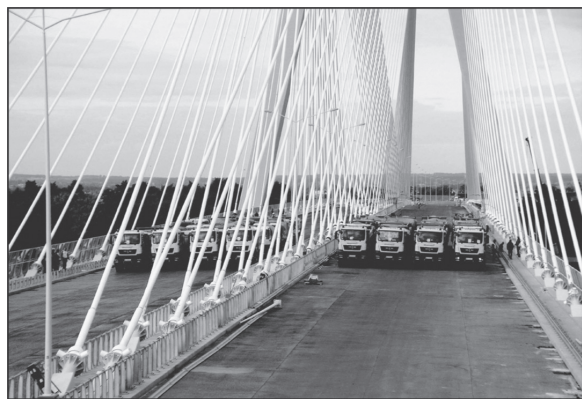
図 - 12 静的荷重試験—荷重ケース S2 (写真：M. Kuzawa)
