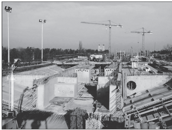
図 - 10 主橋梁部の主桁製作状況
