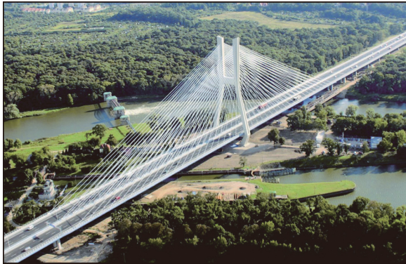
図 - 15 橋梁完成写真
