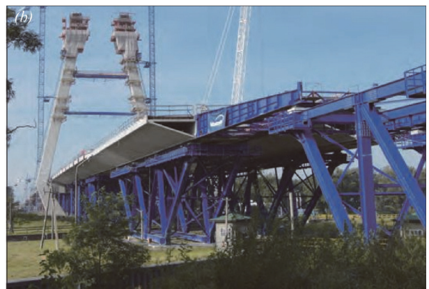
図 - 8 主橋梁の押し出し施工 : (a) 仮支柱で支持された主桁, (b) トラス支保工併用の水路上の押し出し施工
