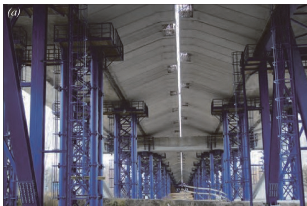
図 - 8 主橋梁の押し出し施工 : (a) 仮支柱で支持された主桁, (b) トラス支保工併用の水路上の押し出し施工
