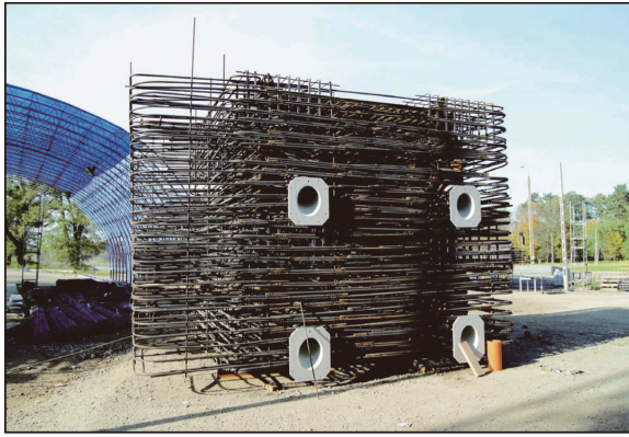
図 - 6 斜材定着部に設置される鋼殻セグメント (鉄筋の先組み完了後)
