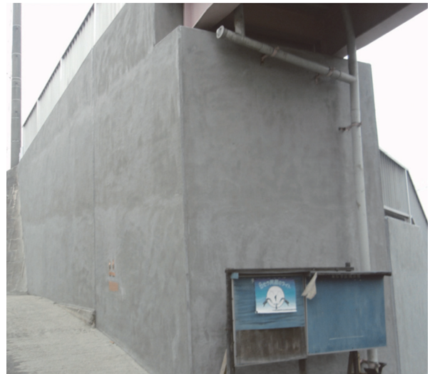
写真 - 3 補修後の状況（A1橋台）
