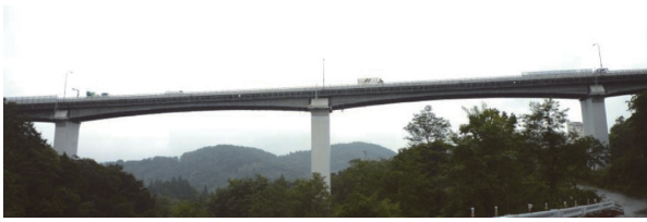
写真 - 1 4 径間連続 PC 箱桁橋
