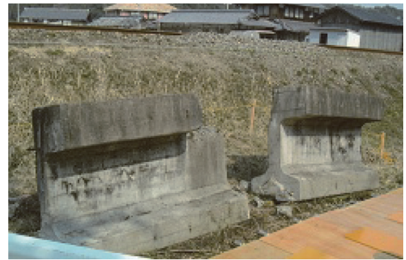
写真-2 線路脇に静置されている標準桁 1)
