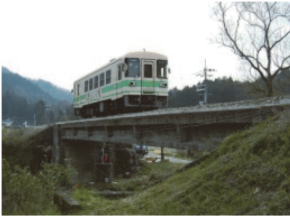
写真-1 第一大戸川橋梁
