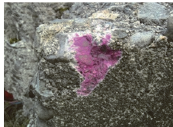
写真-3 標準桁の中性化深さ測定 1)
