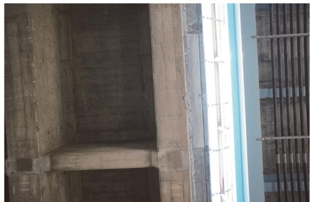
図 - 5 無人飛行体で撮影されたコンクリート表面
