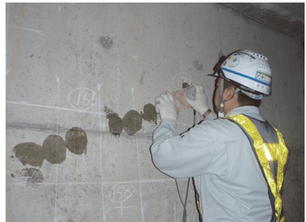
写真 - 4 グラウト充填探査状況
