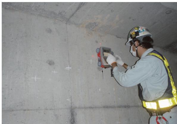
写真 - 3 PC ケーブル位置探査状況
