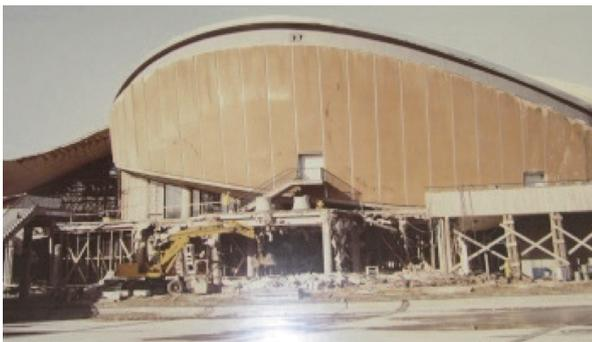
写真 - 10 ドイツでの PC 鋼材破断（崩落時の状況）
