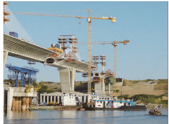
図 - 6 航路部での施工状況
