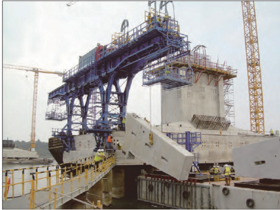
図 - 4 船舶衝突防止工組立て
