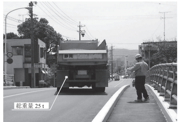
写真 - 9 荷重試験実施状況
