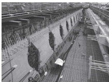
写真 - 12 バタフライウェブパネル架設状況
