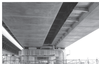
写真 - 14 子セグ部上部工検査路
