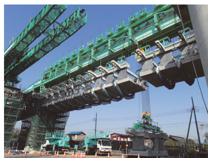
写真 - 7 セグメント吊上げ状況
