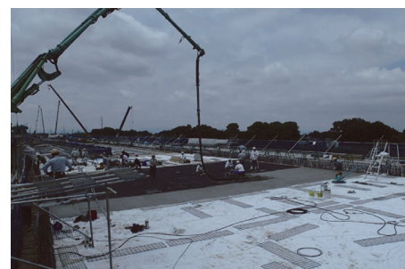
写真 - 11 2主箱桁部上床版2ロット打設状況
