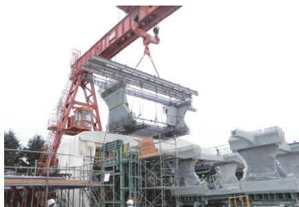
写真 - 5 鉄筋建込み状況
