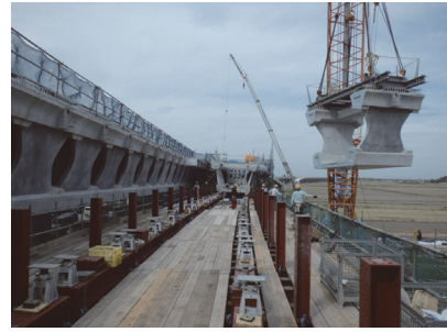
写真 - 10 子セグ架設状況
