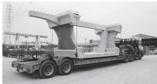
写真 - 1 バタフライウェブを用いた U 形コアセグメント
