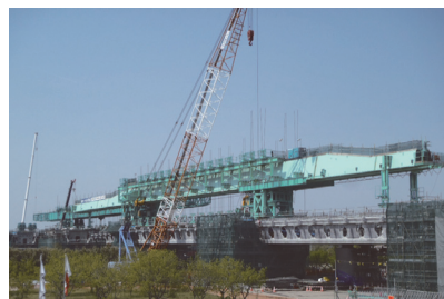
写真 - 6 架設桁による施工状況
