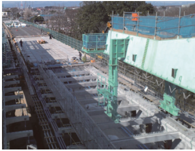
写真 - 8 上床版施工状況
