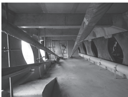
写真 - 13 2室箱桁部の桁内
