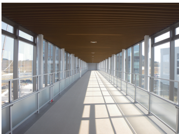
写真 - 6 橋面工・上屋施工完了
