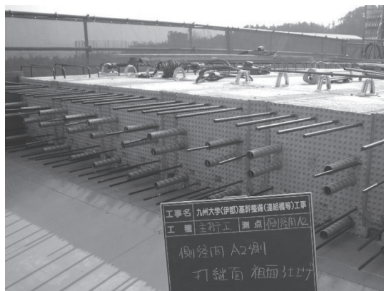
写真 - 4 接続部打継面処理状況
