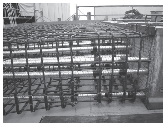
写真 - 5 接続部施工状況
