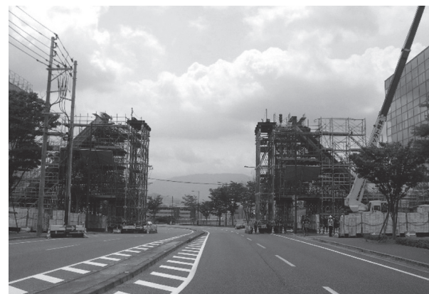
写真 - 2 プレキャスト桁架設前全景
