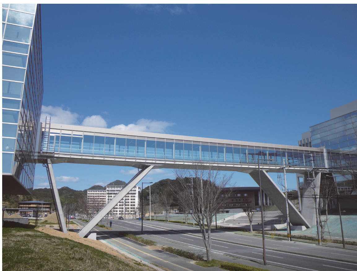
写真 - 7 完成連絡橋全景
