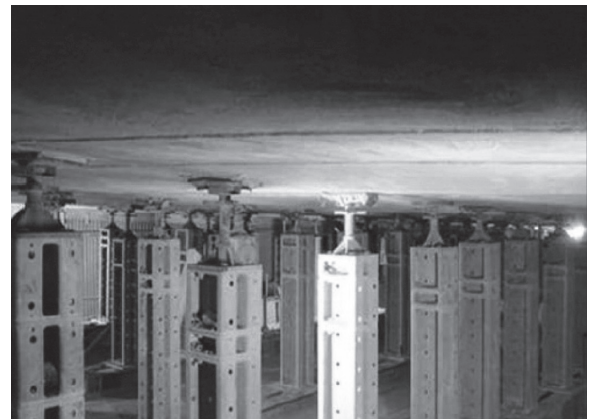
図 - 10 補強後の桁下面
