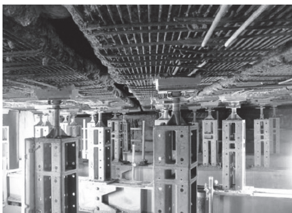
図 - 9 補強前の桁下面
