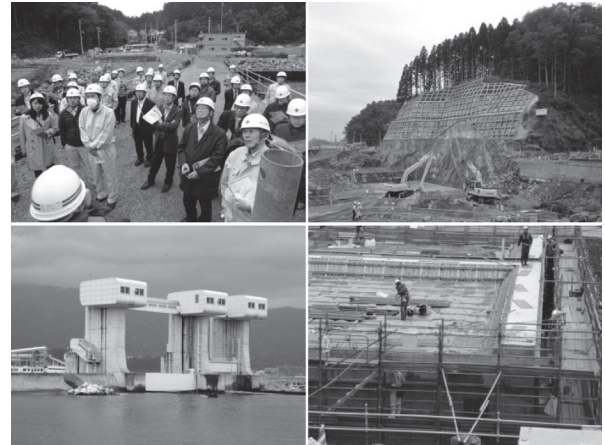
写真 - 3 気仙川水門工事の見学状況
