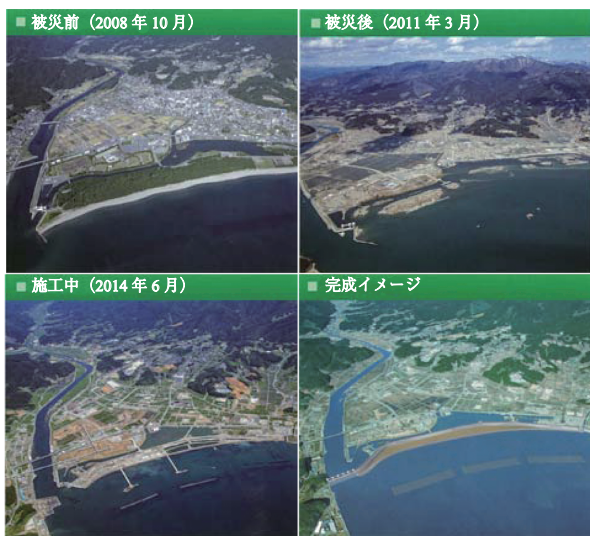
写真 - 5 上空写真と工事の進捗状況 （高田地区海岸災害復旧工事パンフレットより）
