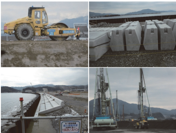
写真 - 4 防潮堤工事の見学状況
