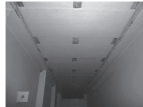
写真-7 炭素繊維格子貼 写真-8 炭素繊維貼付および樹脂塗料の塗布
