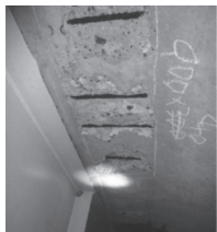
写真 - 1 鉄筋露出状況 写真 - 2 塩化物イオン濃度測定 の粉末採取
