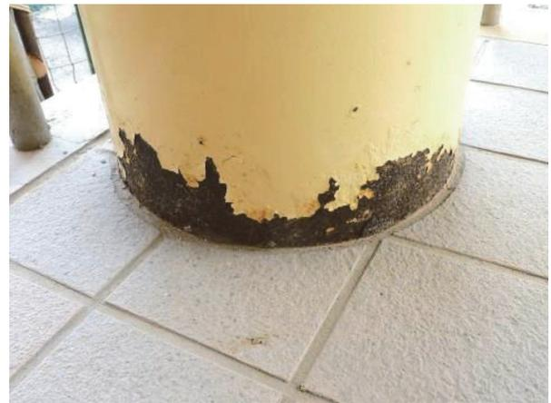
写真 - 5 震災後わずか4年で腐食が顕在化した津波被災地域の学校施設 (2014年12月筆者撮影)
