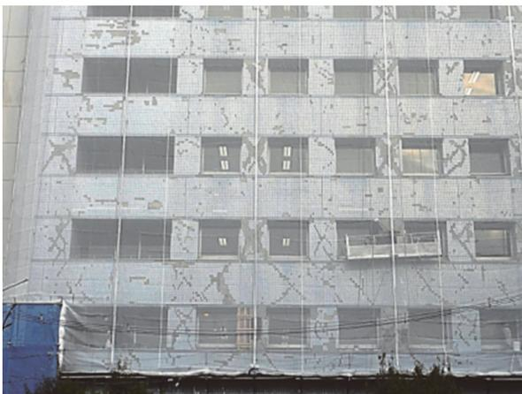
写真 - 4 震災により多数の箇所にタイルの剥離が生じた建築物 (2012年2月筆者撮影)
