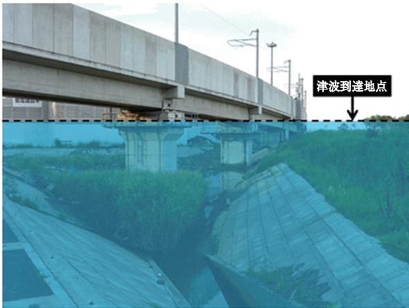
写真 - 3 震災により津波の襲来を受けたコンクリート構造物の例 (2011年7月筆者撮影, 着色範囲は津波のイメージ)
