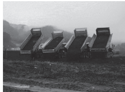
写真-3 釜石市鶴住居地区への土砂提供
