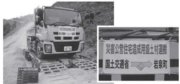
写真-2 建設発生土の運搬トラック
