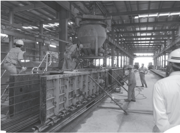
写真 - 6 試験体のコンクリート打設状況
