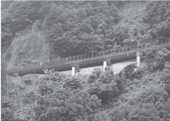
写真 - 2 湖山橋の外観
