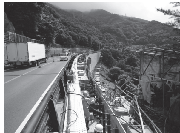
写真-3 湖山橋解体前の全体像
