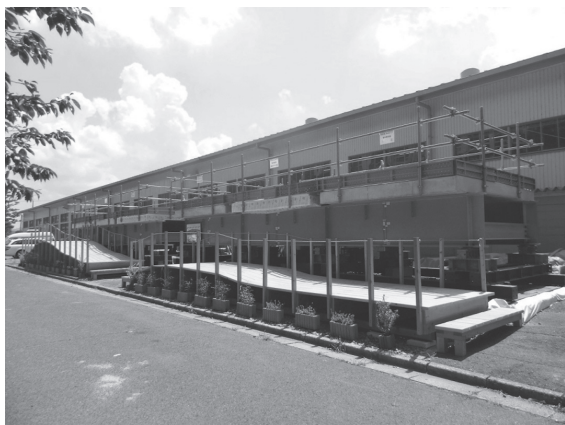
写真 - 6 実物大鋼主桁上コンクリート床版の全体像
