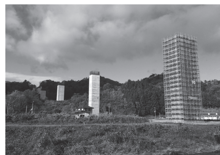
写真 - 1 施工状況写真
