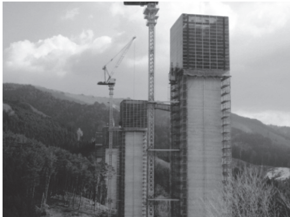
写真 - 11 脚頭部施工時の防寒囲い
