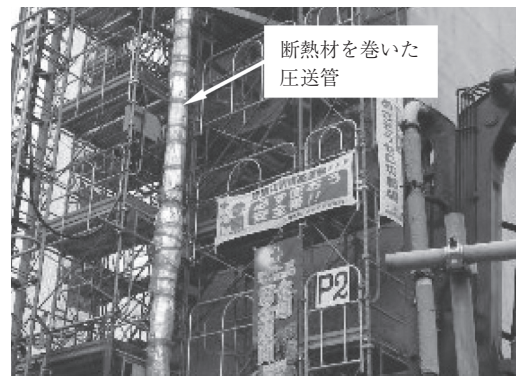
写真 - 9 圧送管の配管状況
