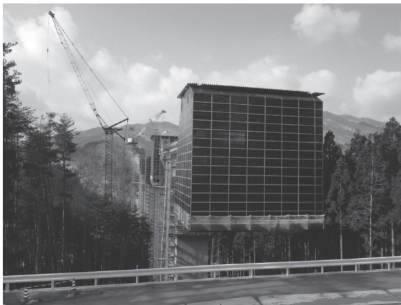
写真 - 12 移動作業車の防寒囲い
