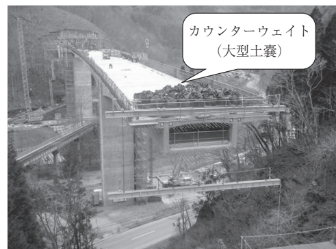
写真 - 2 カウンターウェイト設置状況
