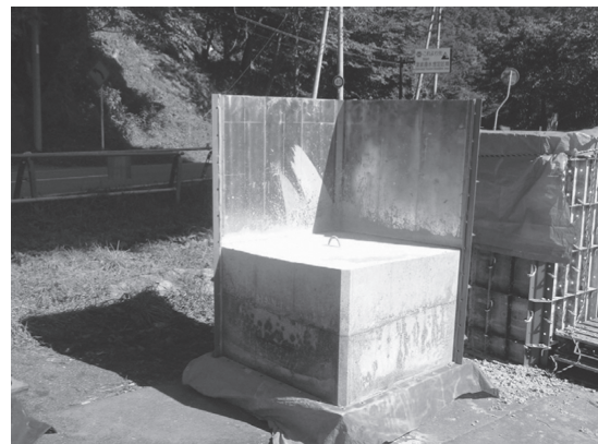
写真 - 5 アンカーブロック製作状況
