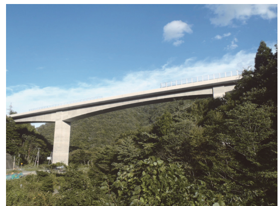
写真 - 10 水海高架橋完成（上流側より望む）
