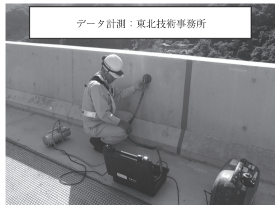
写真 - 4 透気試験状況
