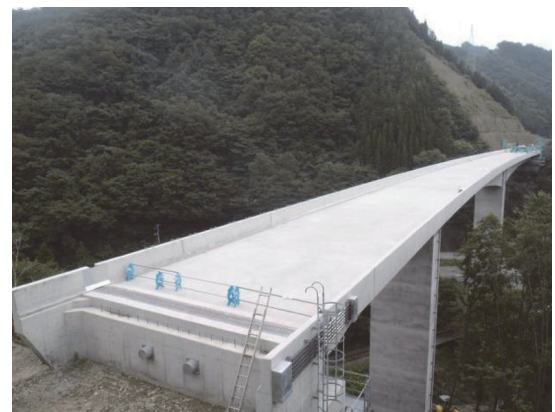
写真 - 11 水海高架橋完成（起点より望む）
