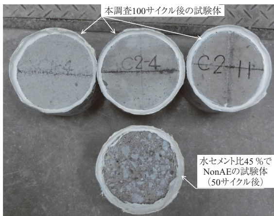
写真 - 3 試験後のスケーリング状況
