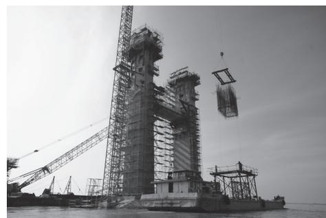
写真 - 2 主塔鉄筋のプレファブ化
