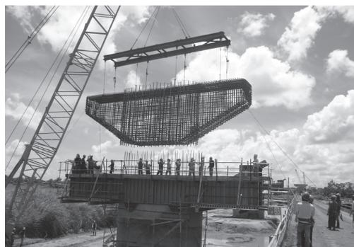
写真 - 9 橋脚鉄筋のプレファブ化
