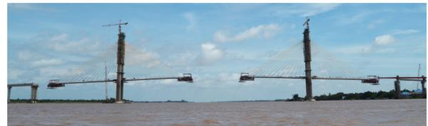
写真 - 5 片持ち架設施工状況
