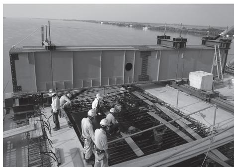
写真 - 8 側径間施工時の架設桁設置状況
