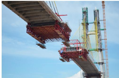
写真 - 6 片持ち架設施工状況
