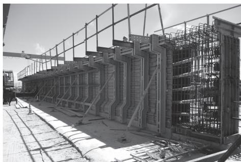
写真 - 10 PCI 桁型枠システム
