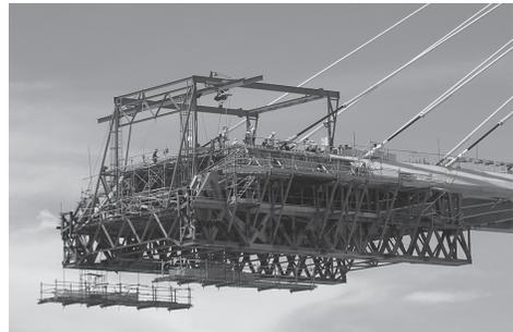
写真 - 4 下支え式移動作業車
