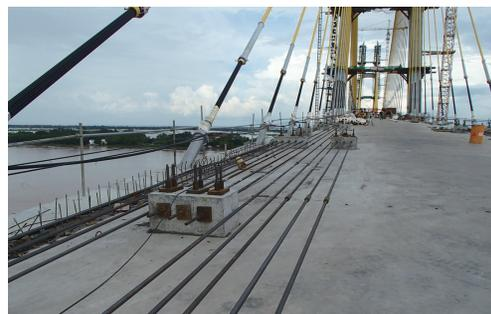
写真 - 7 仮設外 PC 鋼棒配置
