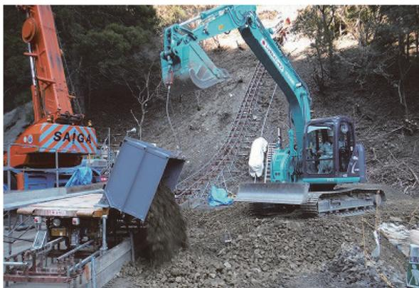
c) 搬出ヤードでの土砂荷卸し
