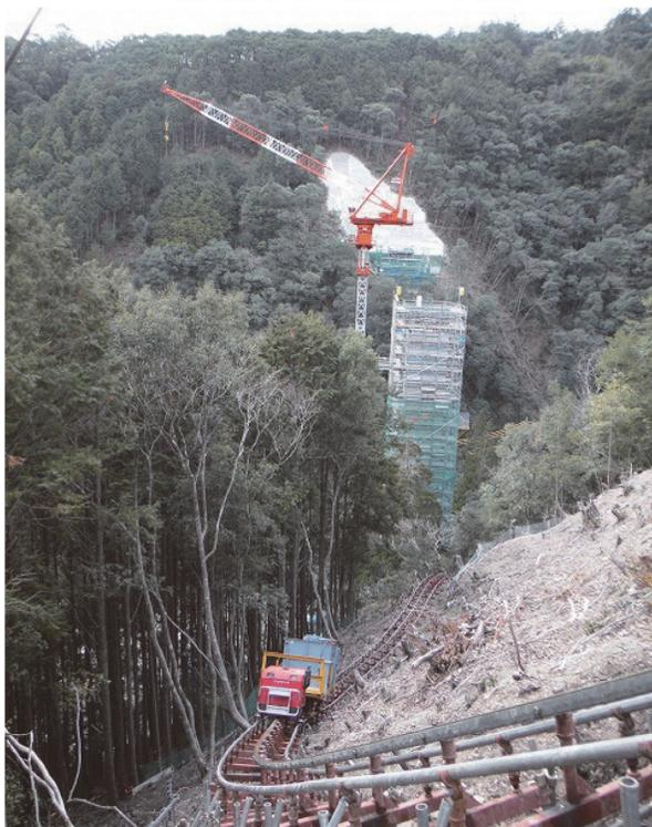
b) 急峻な斜面での土砂運搬
