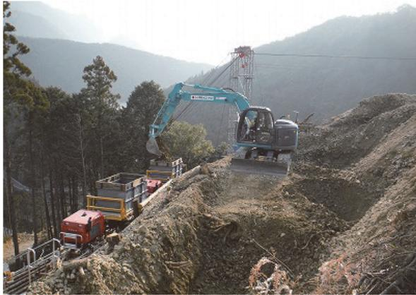
a) A1 橋台設置位置の掘削・土砂積込み
