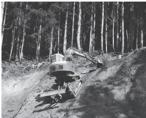
写真 - 2 高所法面掘削機による作業
