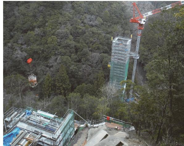
写真 - 5 ケーブルクレーンによるコンクリート運搬
