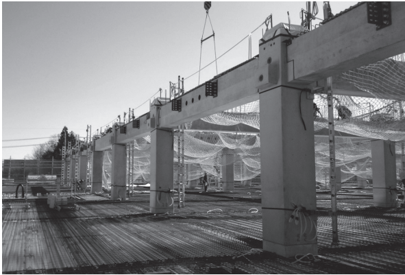
写真 - 1 梁とガセットプレート
