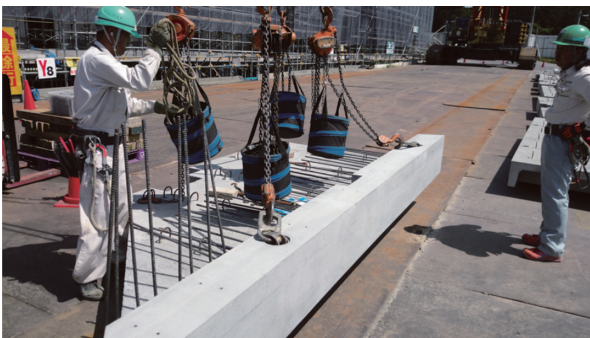
写真 - 7 隅角部バルコニーの揚重
