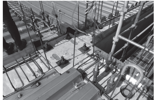
写真 - 4 鉄骨ブレースアンカーボルト
