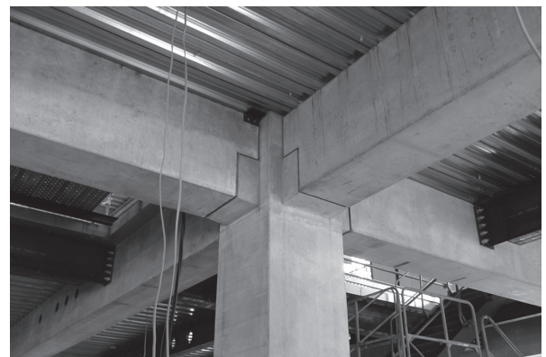
写真 - 5 柱 - 梁接合部
