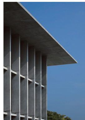
写真 - 13 R 階底外観
