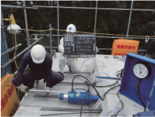
写真 - 9 R 階底の PC 緊張状況
