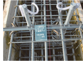
基礎内 PC 鋼棒
