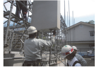
PCaPC 細柱 建方
