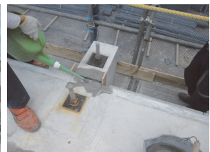
目地モルタル
