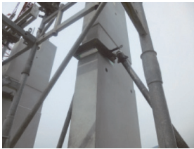
写真 - 10 細柱建ち調整
