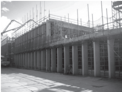
写真 - 7 ST 版からの吊足場
