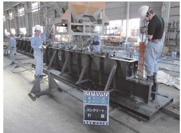
写真 - 4 羽子板状バイブレーター使用状況
