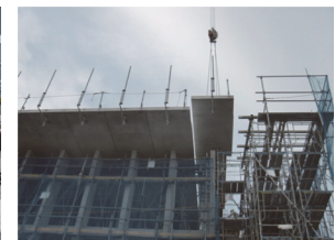
R 階 ST 版 建方
