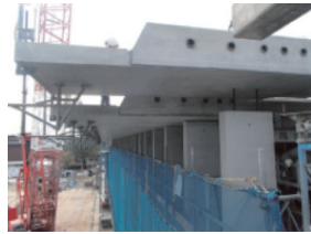
写真 - 11 R 階 ST 版架設状況
