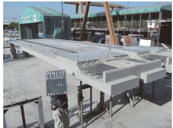
写真 - 5 ST 版ストック状況
