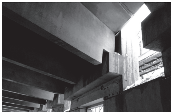
写真 - 9 壁パネル側のアゴ
