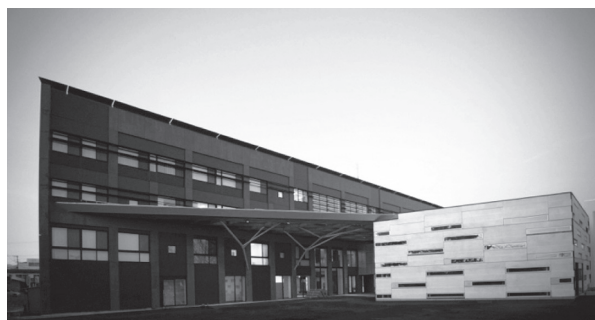
写真 - 1 南立面外観
