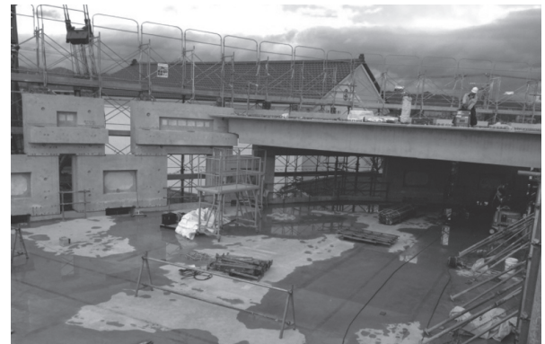
写真 - 10 ST 床版建方中
