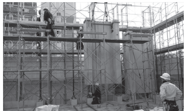
写真 - 9 PCaPC リブ付壁建て方状況 (1)
