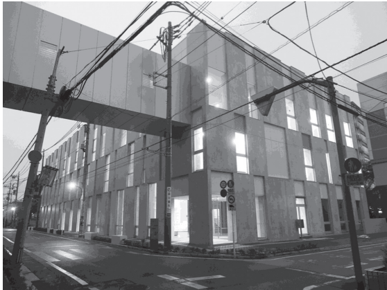
写真-1 建物外観
