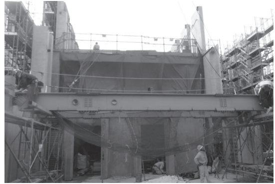
写真 - 13 鉄骨梁建て方状況
