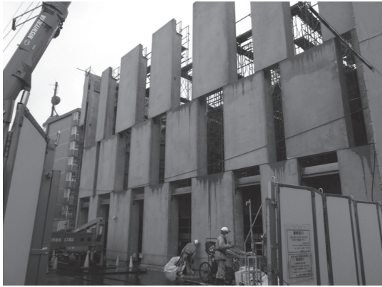
写真 - 10 PCaPC リブ付壁建て方状況 (2)
