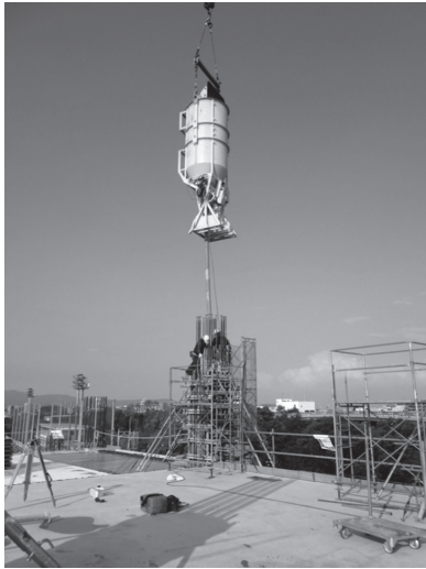
写真 - 3 コンコース部分の柱のコンクリート打設状況
