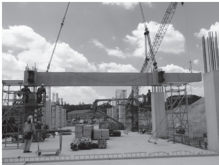
写真 - 4 コンコース部分の PRC 梁の設置状況
