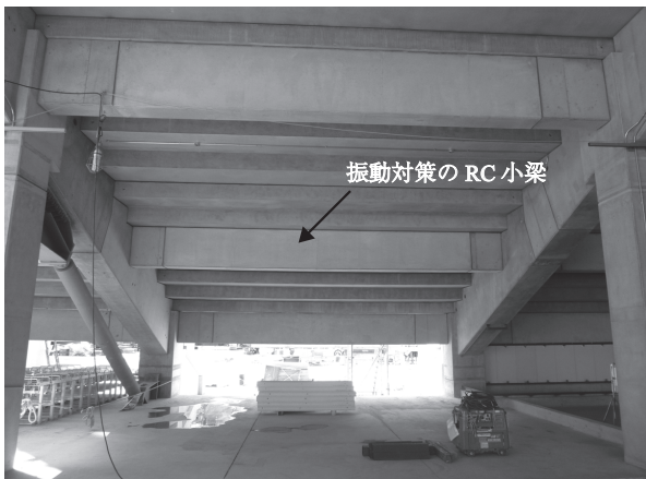
写真 - 1 ホームスタンドに設置した RC 小梁
