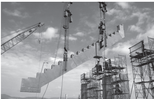
写真 - 10 揚重状況（一般部）
