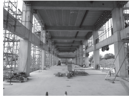
写真 - 7 コンコース部分の施工状況 (床版設置時)
