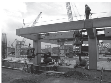
写真 - 5 コンコース部分の跳ね出し部施工状況
