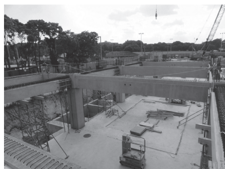
写真 - 6 コンコース部分の施工状況 (2 階梁架設時)
