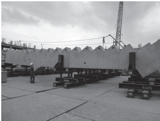
写真 - 8 地組状況（一般部）
