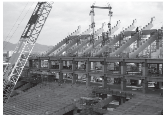
写真 - 11 上段席設置状況（一般部）
