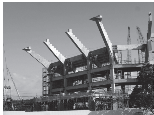
写真 - 12 上段席設置状況（コーナー部）
