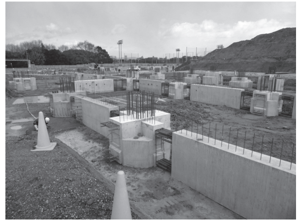
写真 - 2 基礎工事の施工状況
