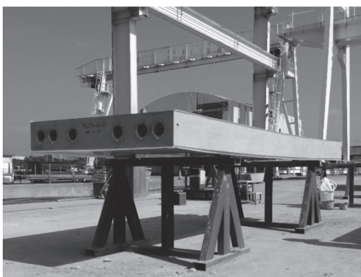
写真 - 8 東材配筋 (上) および下弦材
