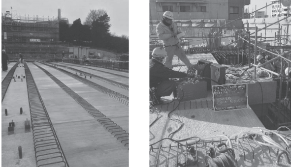
写真 - 12 架設状況 (左) および緊張状況 (右)
