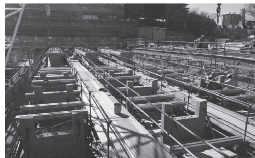
写真 - 11 架設状況
