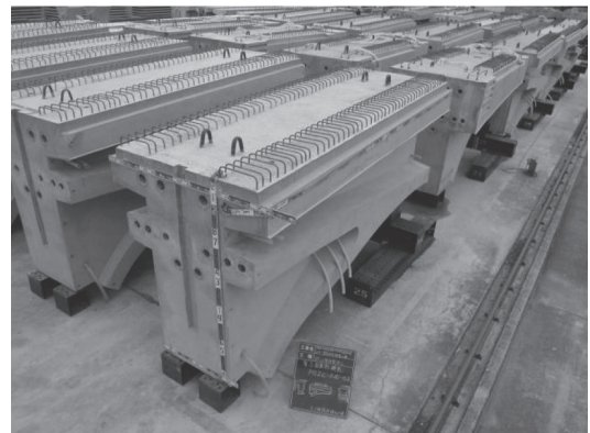
写真 - 7 上弦材 3 配筋 (上) および上弦材 3 部材
