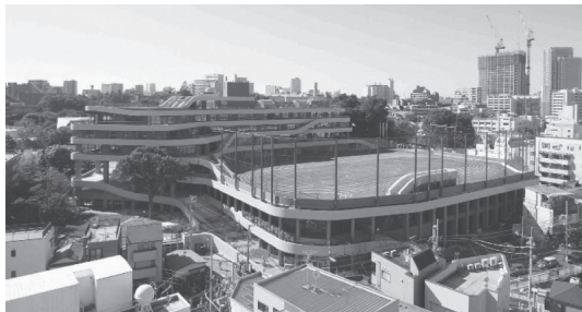
写真 - 1 北東側からの外観
