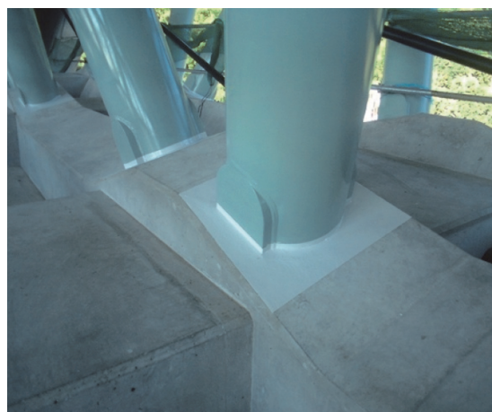
写真 - 3 複合トラス橋の接合部の防錆
