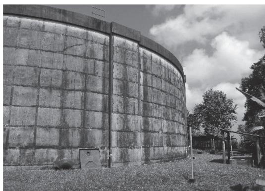
写真 - 3 側壁下端から漏水したPCタンクの例
