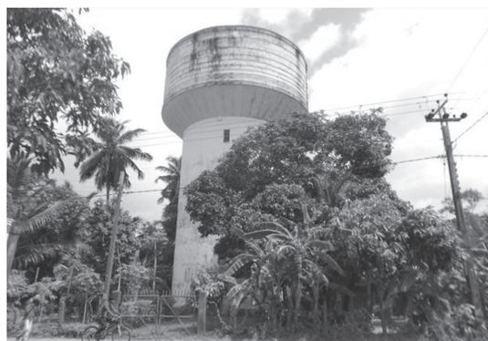
写真 - 2 RCタンクをPC鋼材で補強した例
