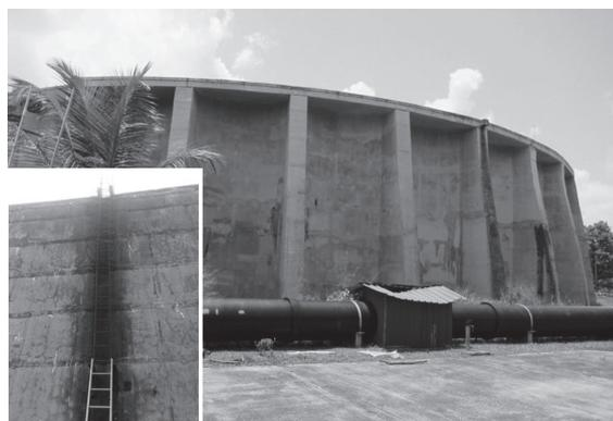
写真 - 1 大型RCタンクを控え壁で補強した例
