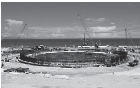
写真 - 1 基礎版鉄筋施工状況
