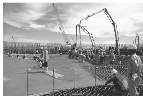
写真 - 3 内側ブロック打込み状況
