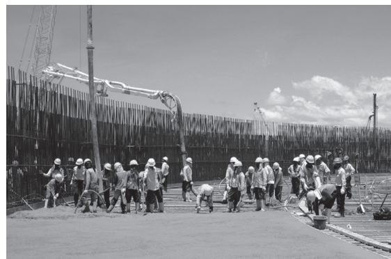
写真 - 2 外周ブロック打込み状況
