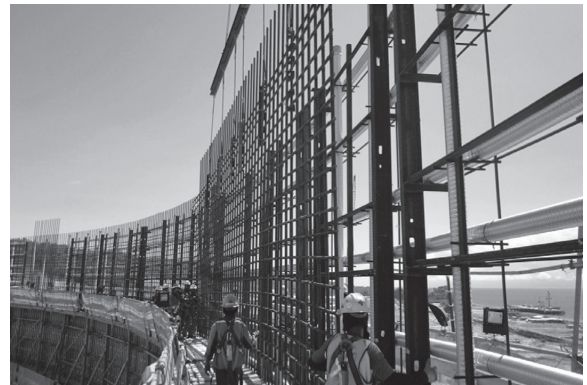
写真 - 8 側壁鉄筋組立て状況
