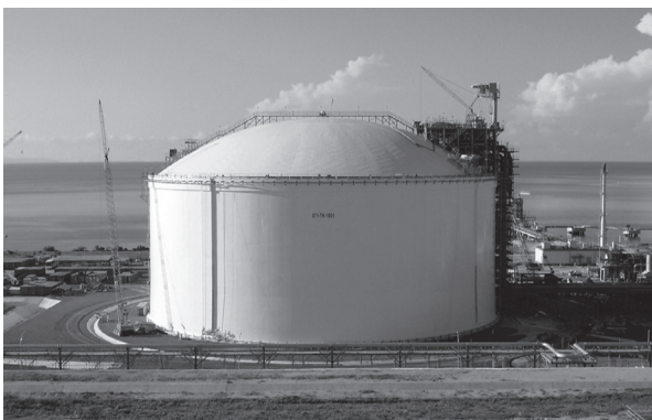
写真 - 13 完成した PCLNG タンク
