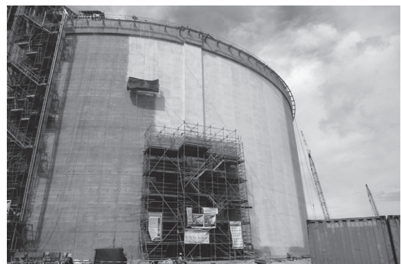
写真 - 12 表面塗装状況
