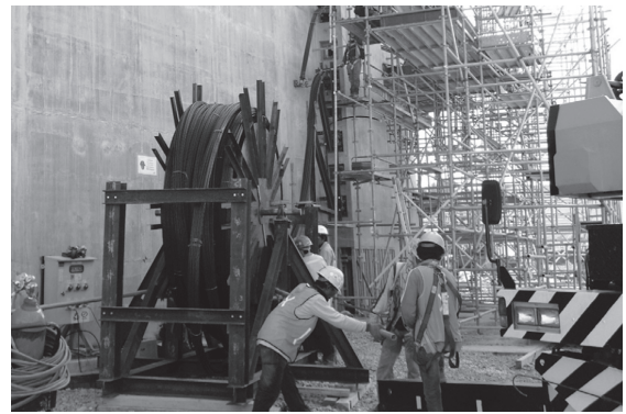
写真 - 11 先行緊張におけるPC鋼材挿入状況
