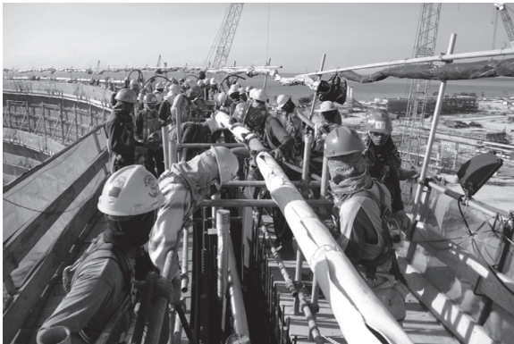
写真 - 10 配管によるコンクリート打込み状況
