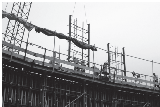
写真 - 6 PCダクト取付け用架台(最終型)
