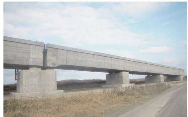
写真 - 11 3径間連続RC床版橋施工完了状況
