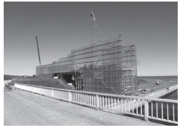
写真 - 4 固定支保工組立て完了状況
