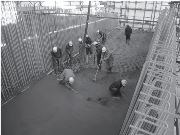
写真 - 5 第2リフトのコンクリート打設状況
