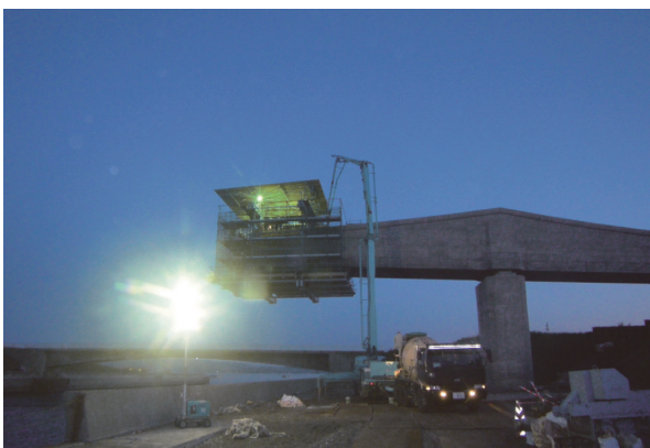
写真 - 9 夜間におけるコンクリート打設状況
