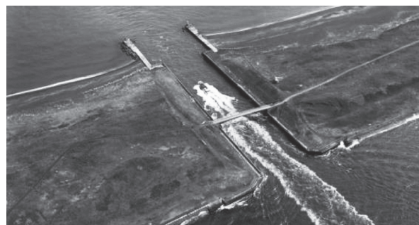
写真-1 橋梁施工前の第2湖口（航路幅50 m）
