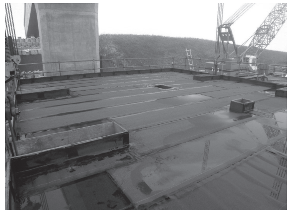
写真 - 3 移動作業車床面シート防水完了状況
