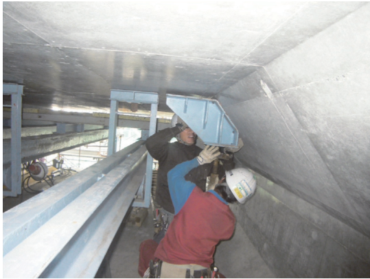
写真 - 8 移動作業車後方アンカー固定用ブラケット
