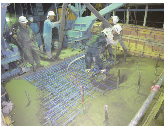
写真 - 10 コンクリート打設状況 (移動作業車内)
