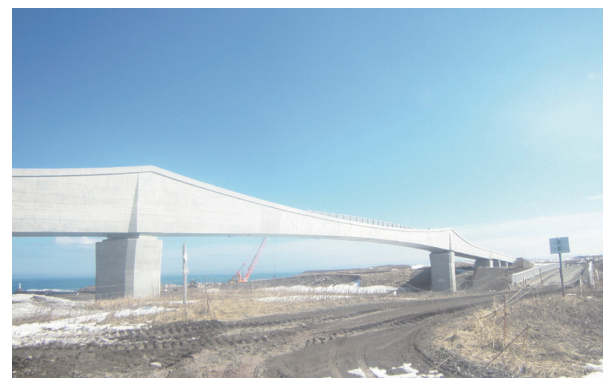
写真 - 12 橋体完成時全景
