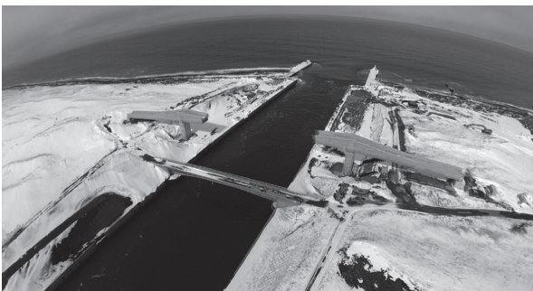
写真 - 6 固定支保工部施工完了時の空撮
