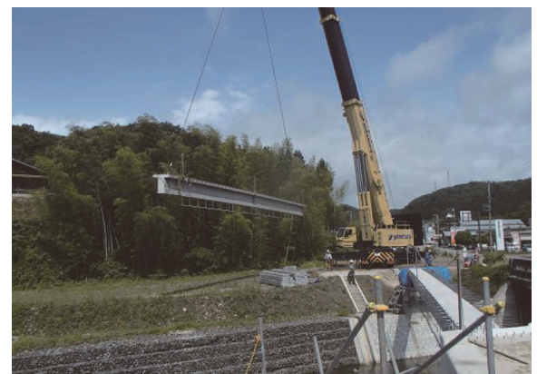
写真 - 3 架設状況 (宮坂橋歩道橋)
